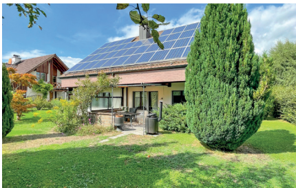
GERLIKON BEI FRAUENFELD 5½-Zimmer-Einfamilienhaus Ruhige Lage, mit grossem Umschwung Verkaufsrichtpreis: Fr. 1'100'000.- Zuständig: Francine Gaggioli
