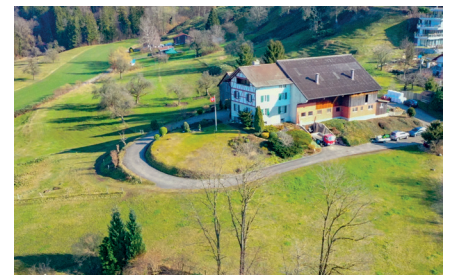
STECKBORN AM UNTERSEE Bauernhaus mit 5570 m 2 Landw.-land Erwerbsmöglichkeit von weiteren 8.36 ha Preis: Fr. 2'200'000.- Zuständig: Andreas Uhlmann
