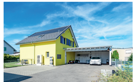
WIGOLTINGEN Einfamilienhaus mit modernster Technik Liebevoll gestaltete Gartenanlage Preis: Fr. 930'000.- Zuständig: Peter Koch
